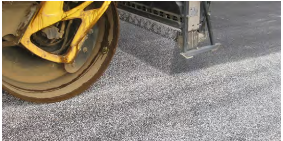
Abb.: Abstreung einer Asphaltdeckschicht mit hellen Gesteinskörnungen; © Ministerium für Verkehr Baden-Württemberg
